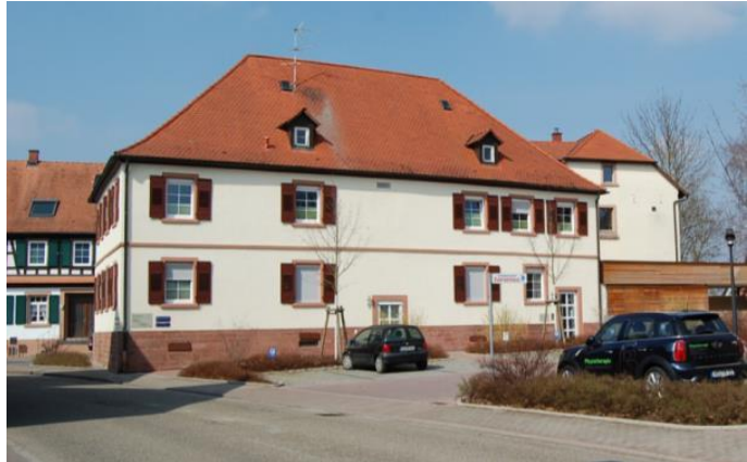
Erstes Gebäude der Willstätter Bürgerstiftung in der Urloffener Straße in Legelshurst.
