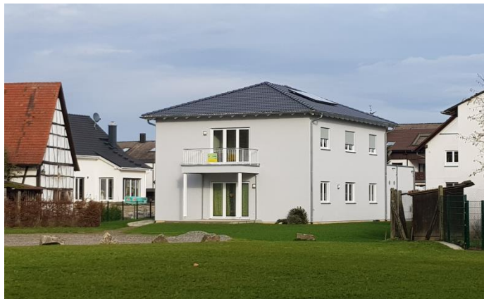
Zweites Stiftungsgebäude der Willstätter Bürgerstiftung in der Amselstraße in Legelshurst.
