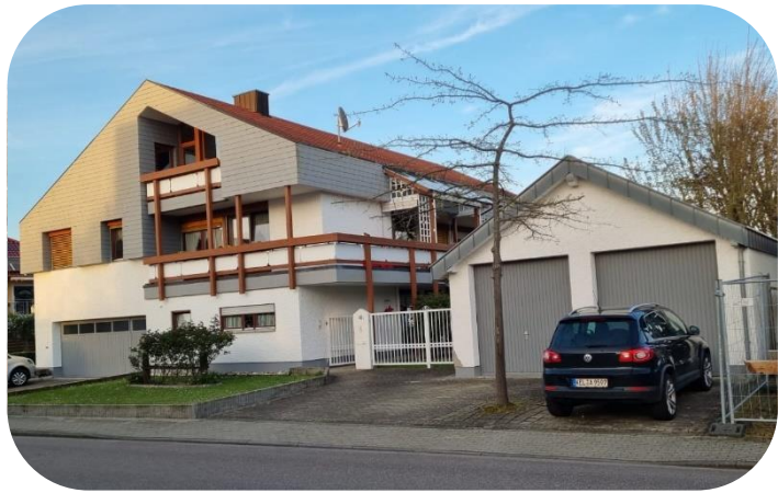
Viertes Stiftungsgebäude in der Eichhofstr. 40 in Willstätt-Sand (Stiftungsfonds Wendling)
