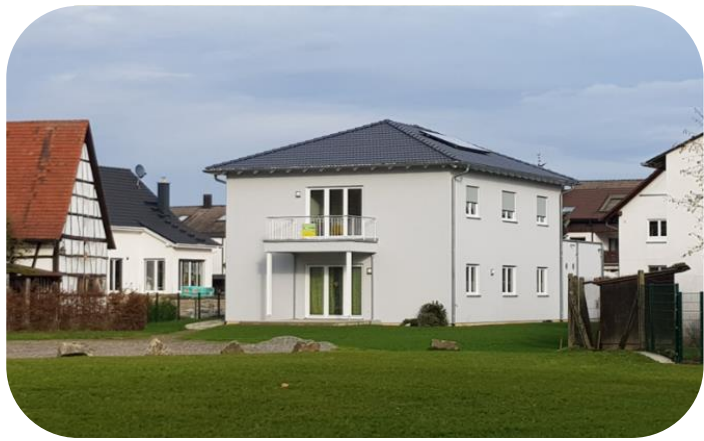
Zweites Stiftungsgebäude der Willstätter Bürgerstiftung in der Amselstraße 12 in Legelshurst
